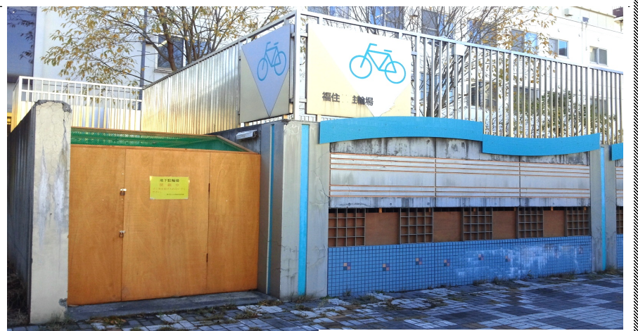
閉鎖されている福住の半地下駐輪場
