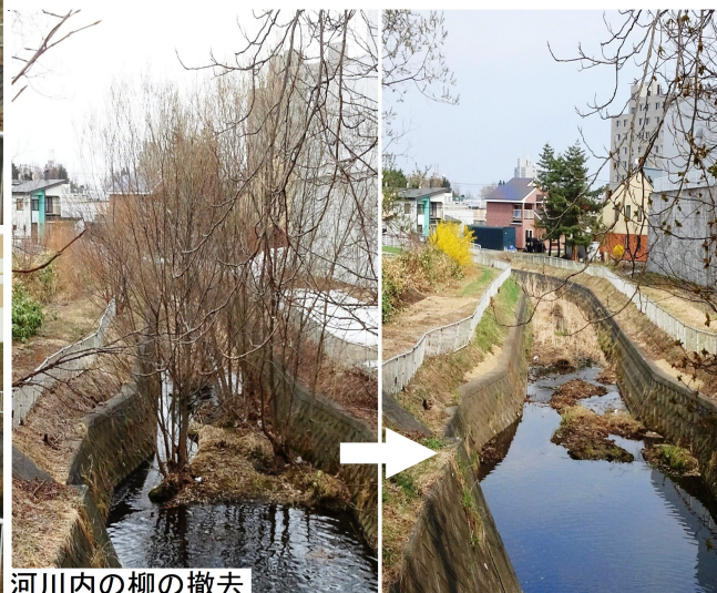
河川内の柳の撤去
